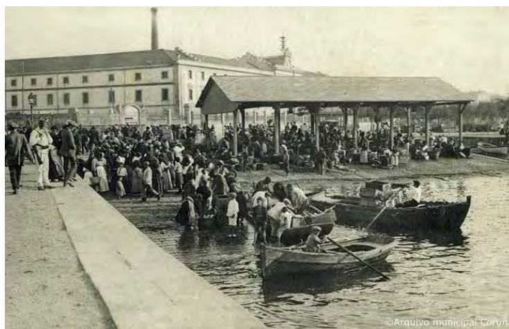
Figura 2. Real Fábrica de Tabacos de A Coruña. Tomada de Archivo Municipal A Coruña.
