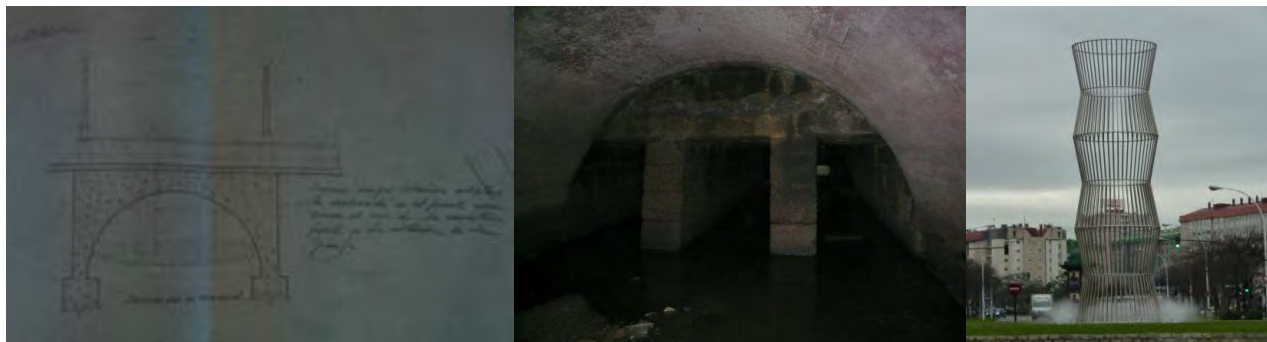
Figura 6. Puente de Monelos, hoy se encuentra bajo la rotonda de la calle Caballeros. De izquierda a derecha: Proyecto de ensanche del Río Monelos (1847). Archivo Municipal de A Coruña; imagen del estado actual del puente dentro del sistema de alcantarillado de Coruña (elaboración propia, 2015); escultura sobre el puente enterrado (elaboración propia, 2015).
