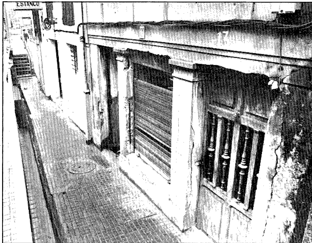
El agua entra fácilmente en las casas ocasionando cuantiosos daños materiales
