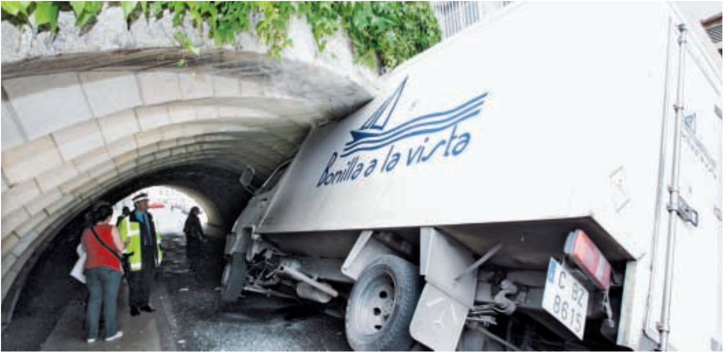
El vehículo quedó apoyado sobre dos ruedas después de colisionar contra la parte más alta de la arcada del túnel, que en ese punto mide 2,20 metros | FOTOS: ÓSCAR PARÍS
